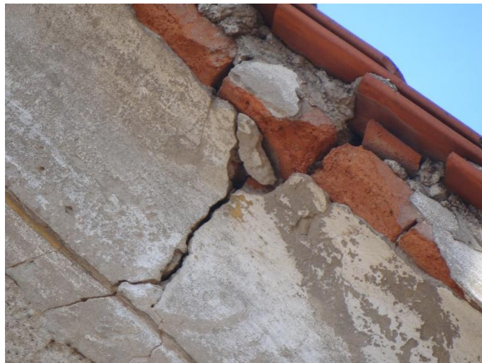
Slika 56: Primer diagonalne razpoke pod streho (graščina Radvanje) (Vir: Lastni vir ( 31.10.2020 ))
