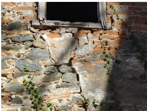
Slika 5: Razpoke pod oknom (graščina Radvanje)
