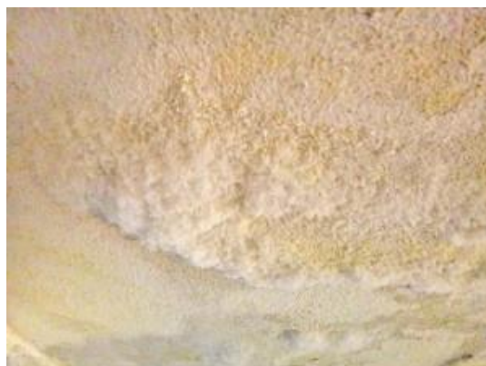
Slika 21: Kristalizacija zidu
