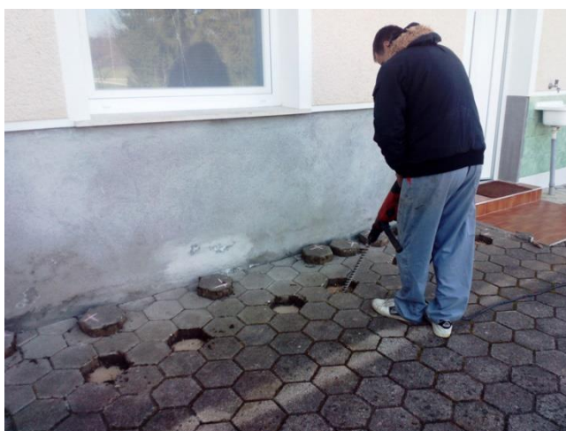
Slika 13: Primer vrtanja vrtin pod temelj hiše
