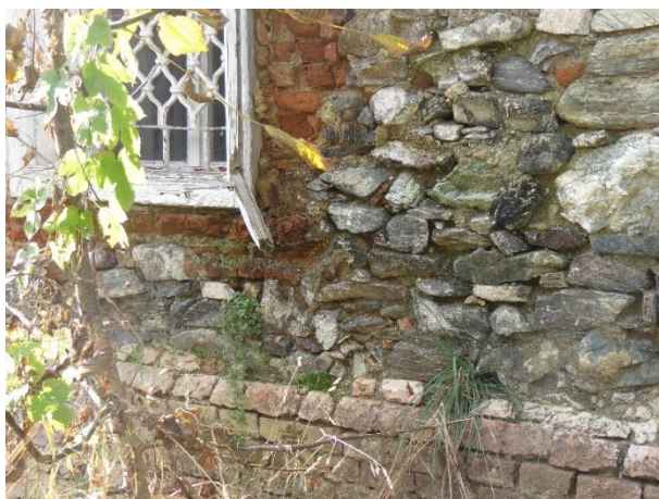
Slika 2: Zid z algami in rastlinjem
