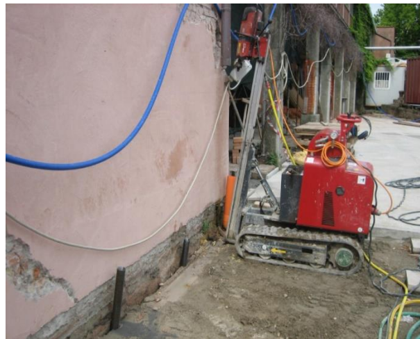
Slika 16: Vrtanje izvrtine za vstavljanje mikropilota.
