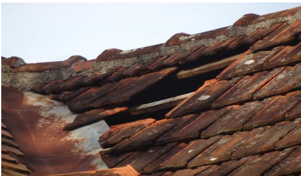
Slika 31: Odkrita streha (slika zunaj)
