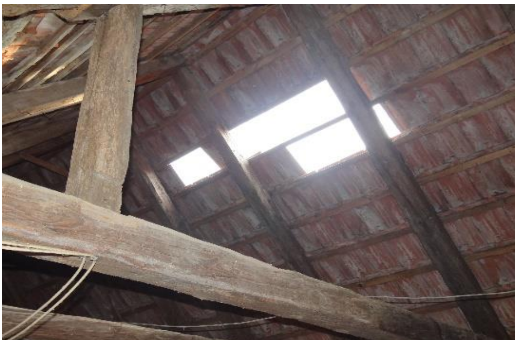
Slika 30: Odkrita streha (slika znotraj)
