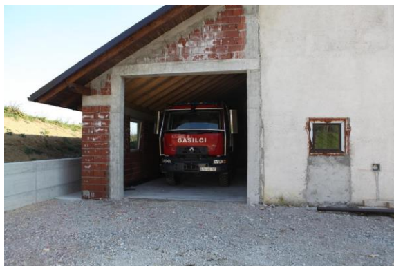
Slika 10: Primer dozidave novega objekta k obstoječemu objektu
