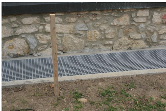
Slika 27: Zračenje zidu z zunanje strani
