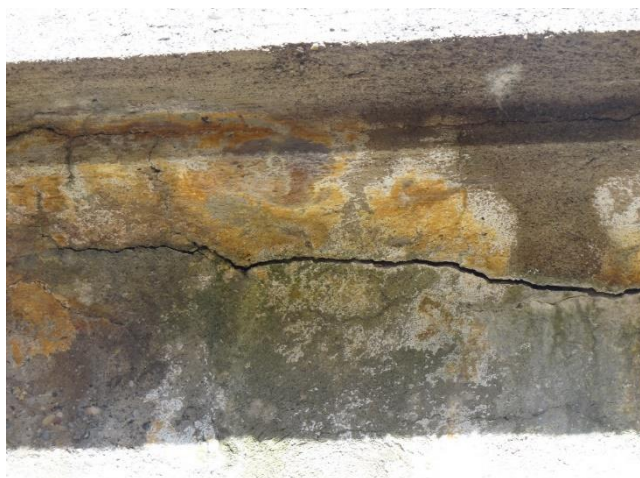
Slika 18: Primer razpoke pod streho (graščina Radvanje) (Vir: Lastni vir ( 31.10.2020 ))
