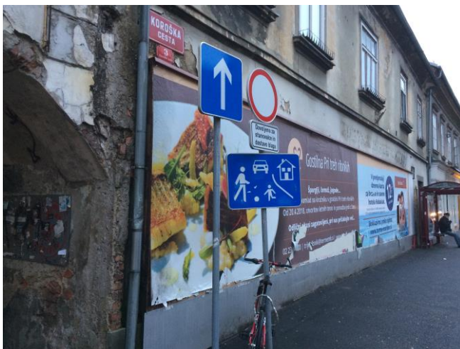
Slika 10: Neprimerna rešitev fasade na Koroški cesti 3 (lasten vir)
