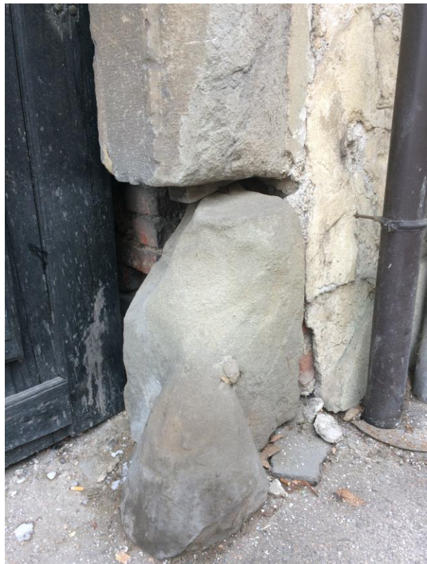
Slika 6: Propadanje kamnitega oddrsalnika (lasten vir)
