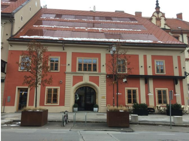
Slika 8: Koroška cesta 2 nekoč in danes (lasten vir)
