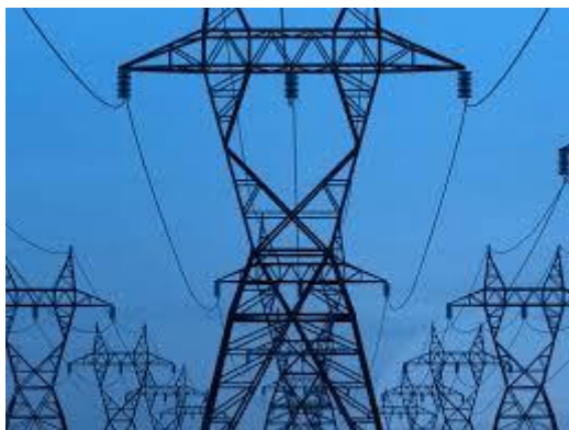
Slika 1, vir: Thermal drone Ltd
