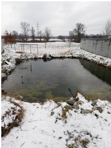
Slika 21 : Ribnik s prečiščeno kanalizacijsko vodo (lasten vir)
