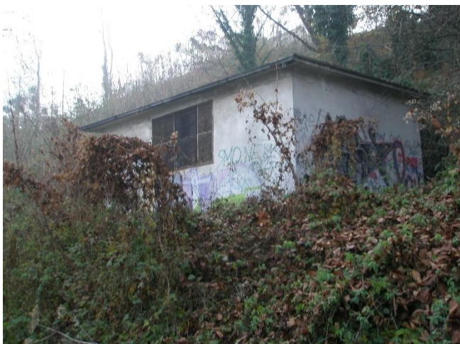
Fotografija: Objekt – črpališče vodno Drava MB (vir: Slovenske železnice)
