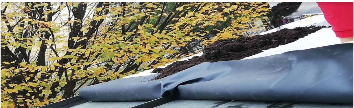
Slika 23: Zasutje plošč sadilnega plastopora z zemljo; lasten arhiv
