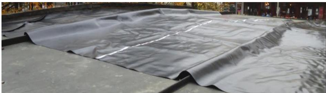
Slika 20: Položena PVC folija za ribnik; lasten arhiv
