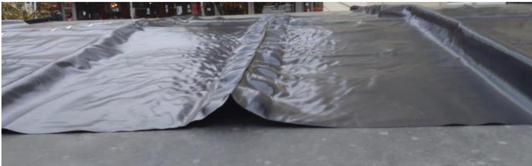
Slika 19: Položena PVC folija za ribnik; lasten arhiv
