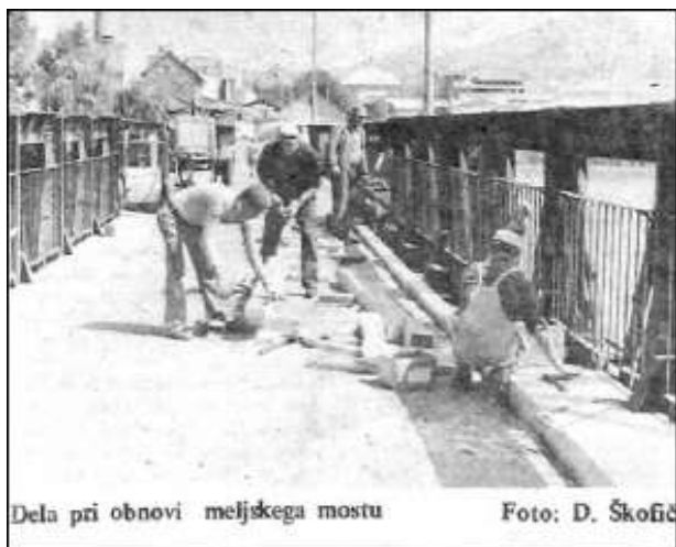
Slika 82: Dela na Meljskem mostu (Vir: Večer, 1. julij 1978, str. 6)
