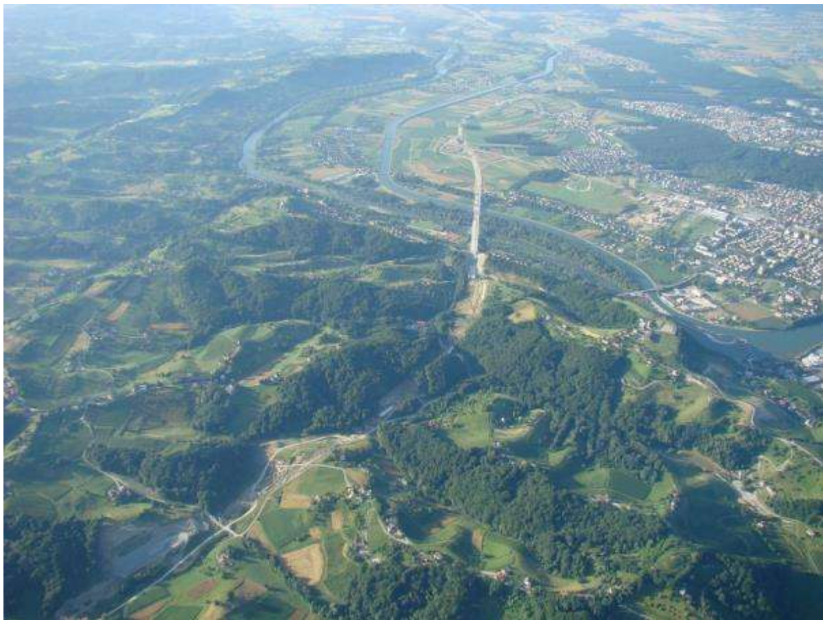
Slika 94: Panoramska slika Mariborske vzhodne obvoznice z mostom (Vir: http://www.panoramio.com )
