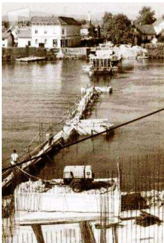
Slika 105: Gradnja mostu (Vir: https://www.kamra.si/digitalne-zbirke )
