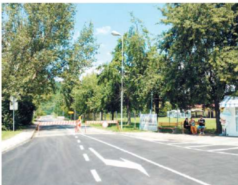
Zaradi prenove most ni prevozen. (Gregor Grosman)
