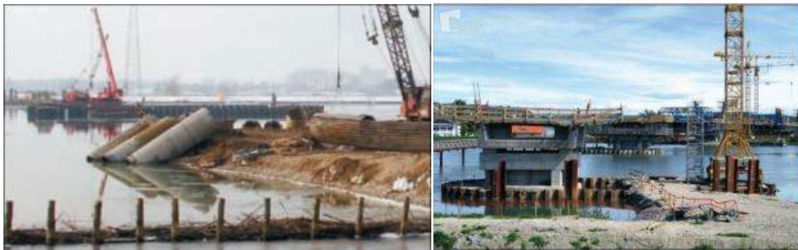
Slika 121: Gradnja mostu (Vir: Večer, 21. januar 2006, str. 18)
