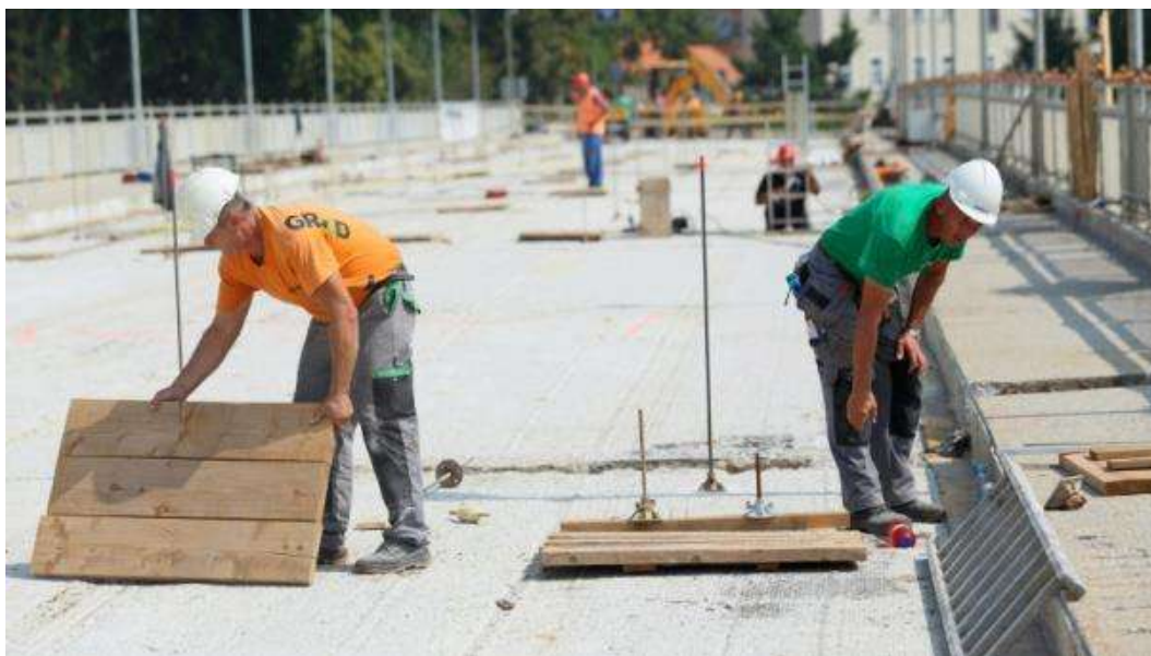
Slika 113: Sanacija mostu (Vir: https://www.tednik.si/gospodarstvo )
