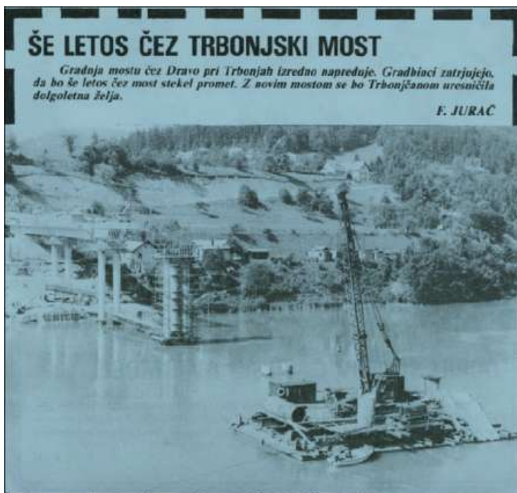
Slika 15: Gradnja mostu (Vir: Viharnik, avgust, sept. 1989, str. 20)
