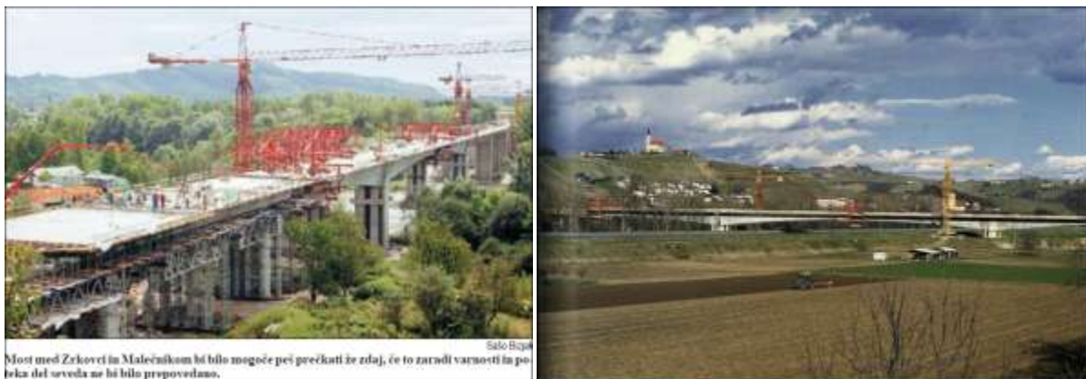
Slika 90: Gradnja mostu (Vir: Večer, 24. avgust 2006, str. 20)
