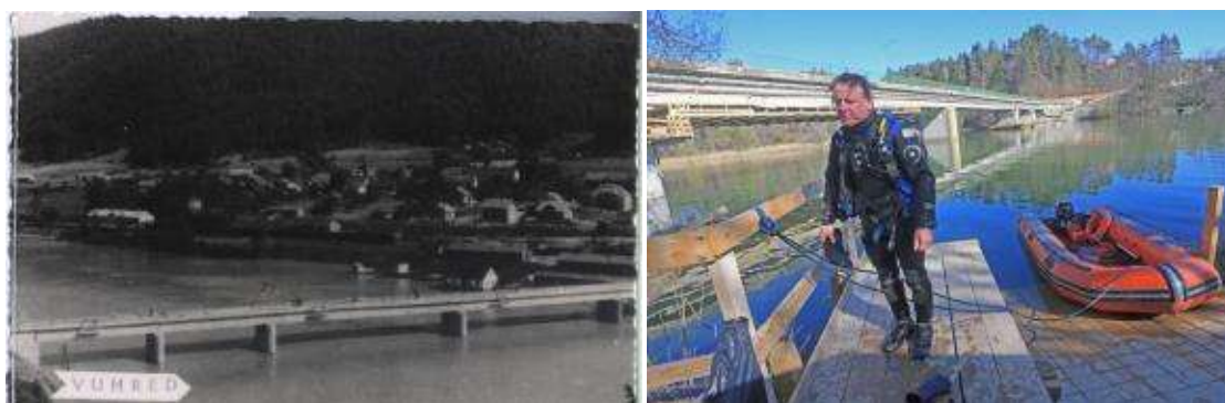
Slika 26: Vuhred 1957 v času zaključevanja izgradnje novega mostu čez reko Dravo (Vir: zasebna zbirka Mirka Kogelnika)
