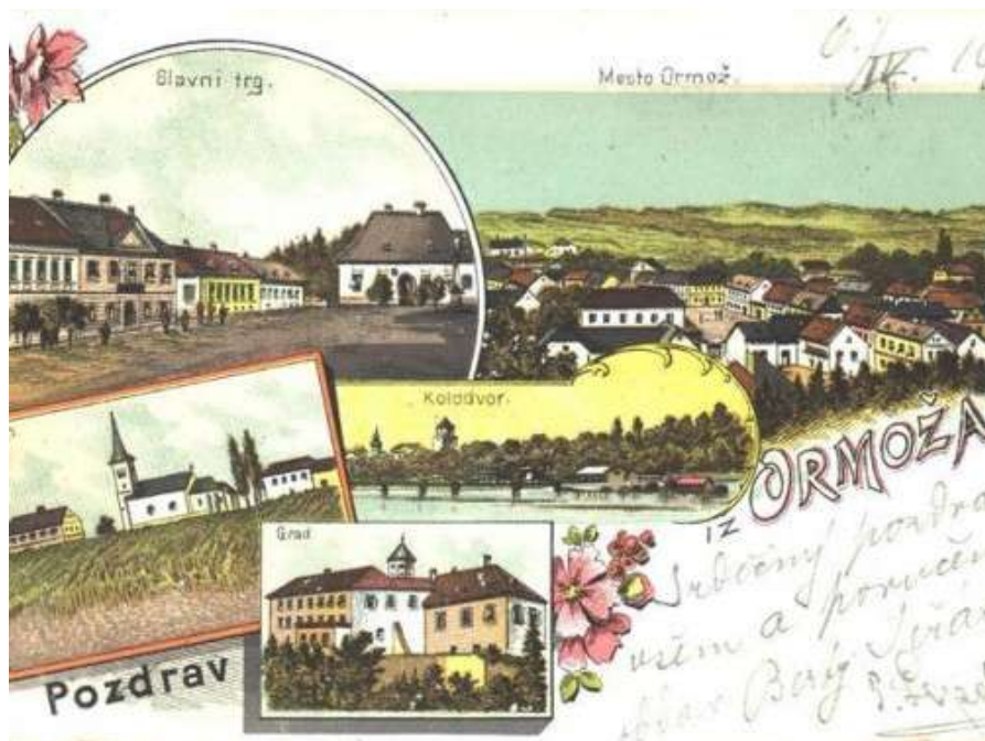
Slika 133: Razglednica iz Ormoža, kjer je viden most čez Dravo leta 1901 (Vir: https://www.kamra. )
