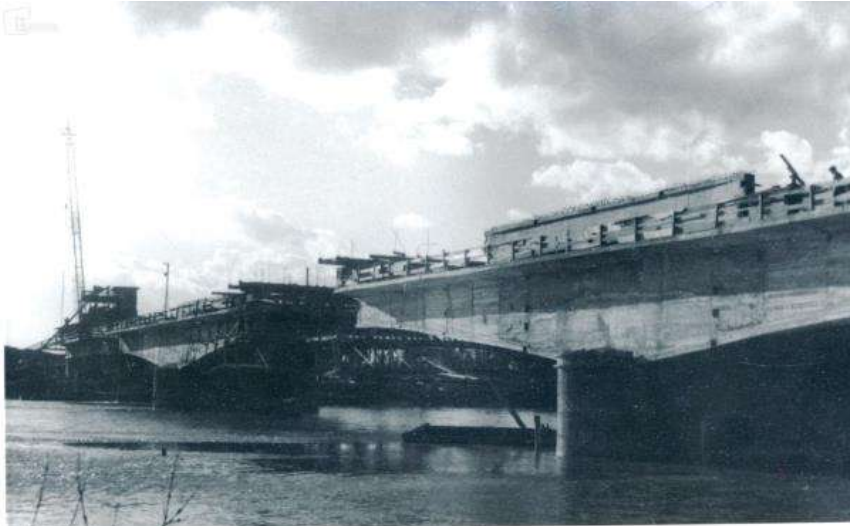
Slika 111: Zaključna dela na Novem (Starem) mostu (Vir: https://www.kamra.si )
