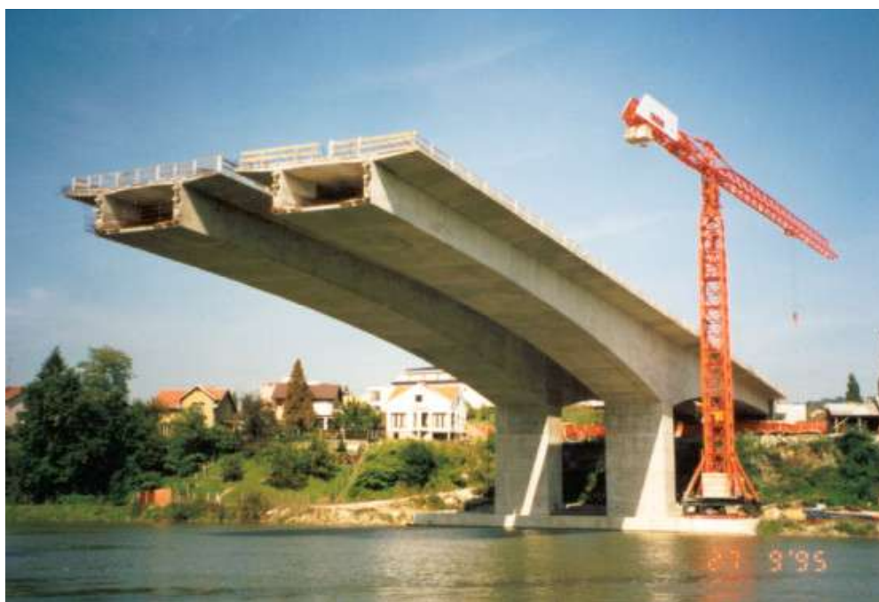
Slika 50: Gradnja mostu (Vir: http://www.mladina.si/46404/slovenska-prestolnica )
