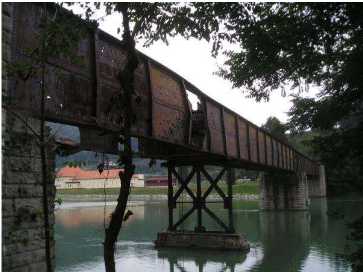
Slika 6: Razpadajoči železniški most (Vir: http://www.vlaki.info/forum/viewtopi )
