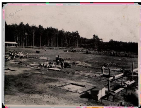
Slika 8: Začetki gradnje tovarne leta 1941
