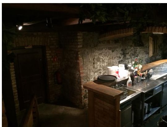
Slika 12: Zazidan vhod v rov
