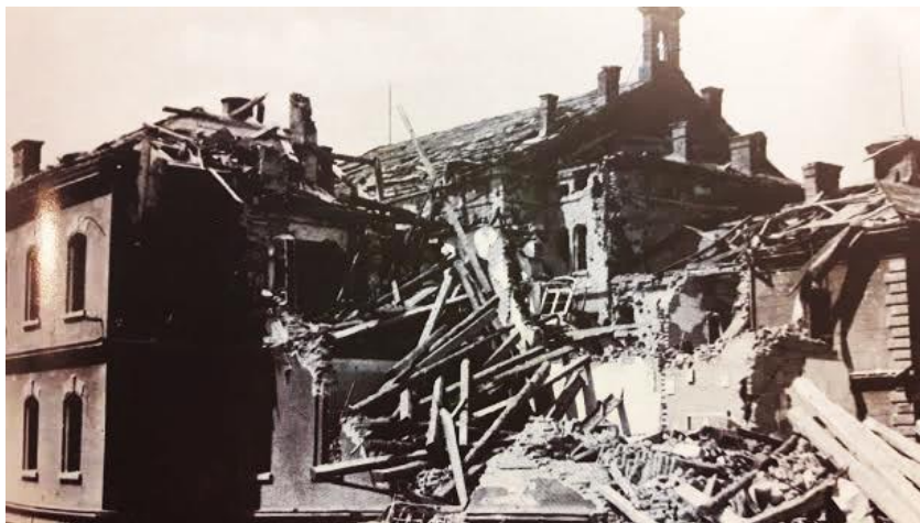
Slika 18: Upravno poslopje moške kaznilnice po bombardiranju 1. aprila 1945. 82
