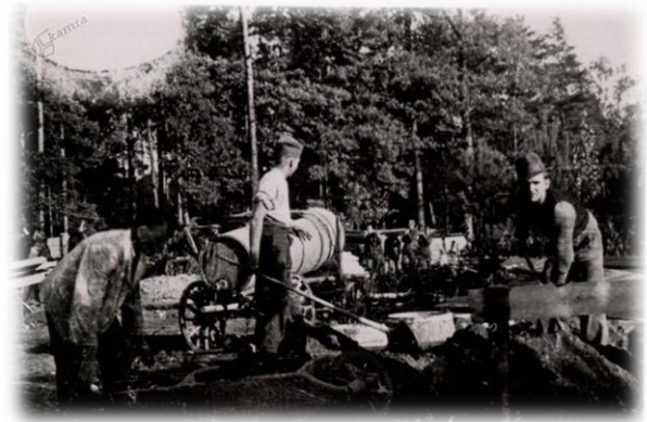
Slika 27: Gradnja tovarne letalskih delov.
