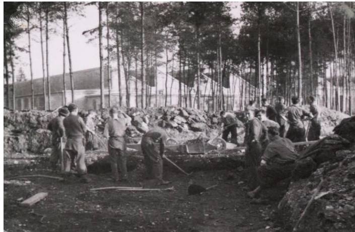
Slika 55: Gradbena dela novembra 1942. Med delavci je bilo mnogo vojnih ujetnikov iz različnih držav. 199
