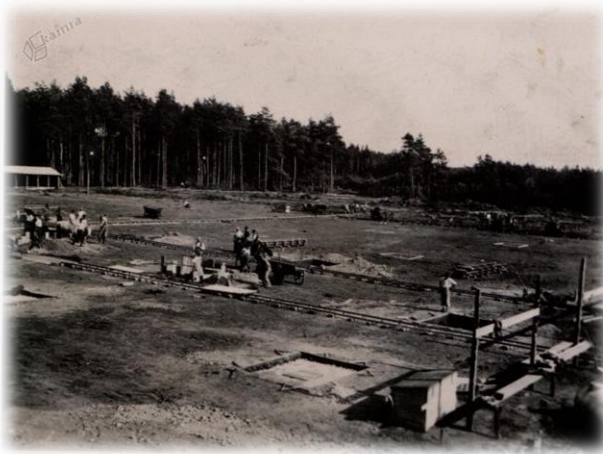
Slika 26: Začetki gradnje, leto 1941. 130
