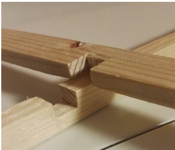
Slika 15: Priploščitvena vez rešetk in prečnikov (osebni arhiv, 2016)
