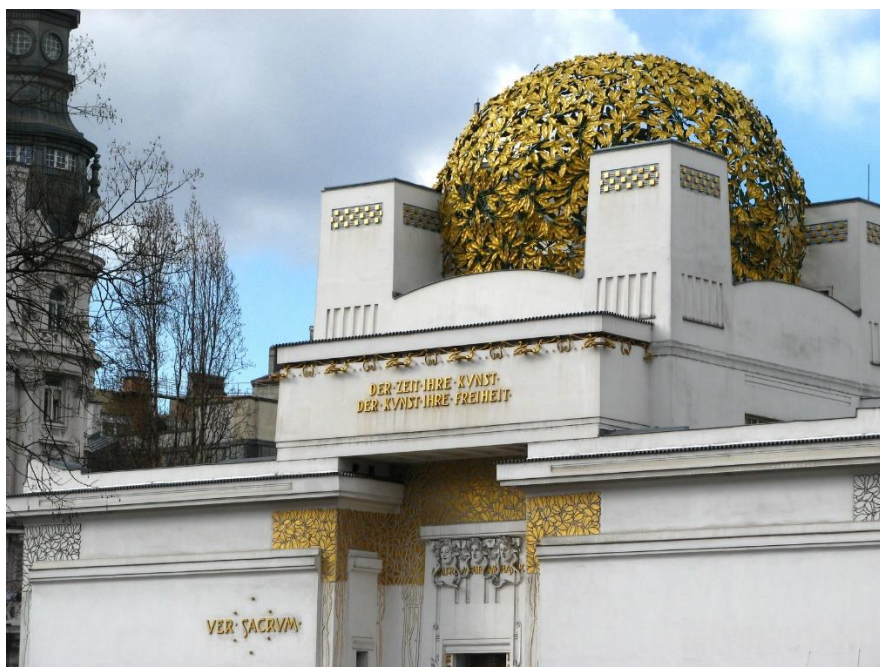
Slika 1: Tipična secesijska stavba (vir: http://upload.wikimedia.org/wikipedia/commons/8/86/20080215-18 Wenen (017).jpg )
