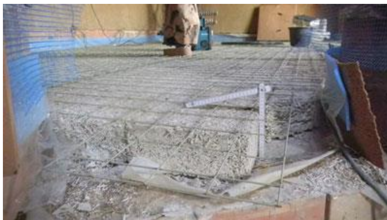
Slika 8: Uporaba konopljne izolacije (vir: http://www.konopko.si/gradbenistvo )
