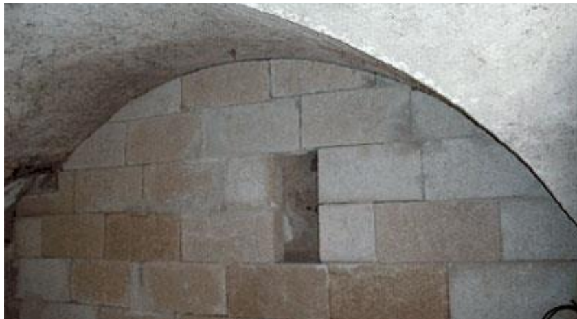
Slika 11: Nosilni konopljini zidaki (z dodanim cementom in magnezijem)
