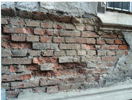
Slika 19: Današnje stanje južnega stanovanjskega objekta – detajl zidu
