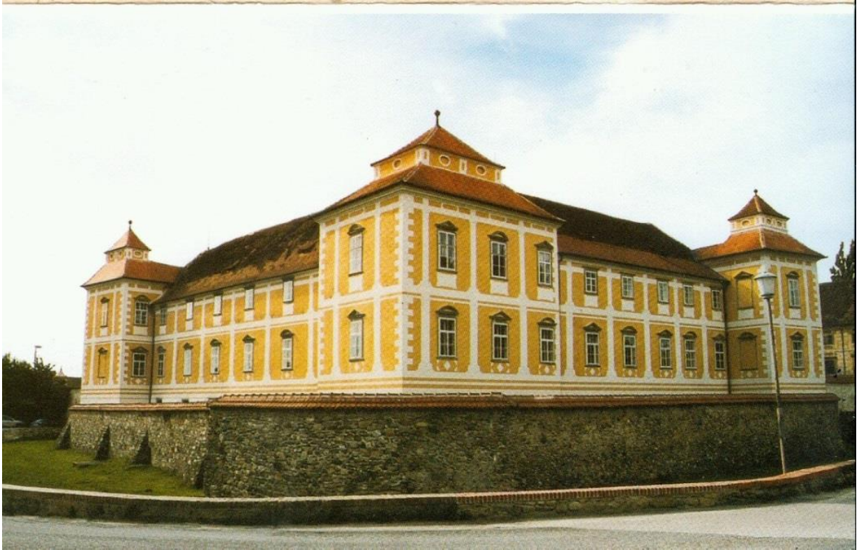
Slika 15: Severni del gradu s poslikano zunanjščino, julij 2001
