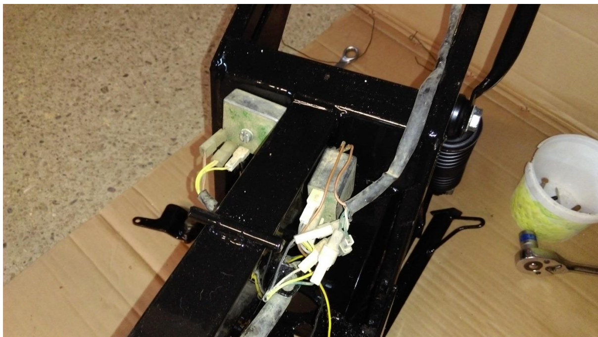
Priklop kablov na okvir
