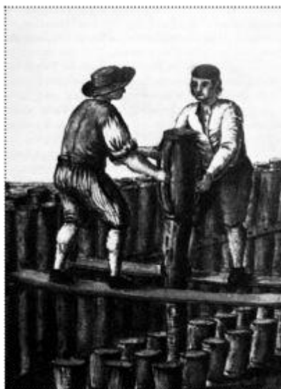
Slika 14: Zabijanje pilotov (Vir: Torelli, 1998, 175)
