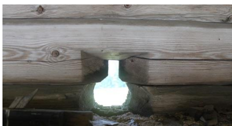
Slika 21: Kneže, v lesene tramove vžagana strelna lina (vir: lastni arhiv)
