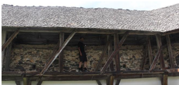
Slika 22: Kneže, višina obrambnega hodnika, ki omogoča namestitev puške na strelno lino (vir: lastni arhiv)
