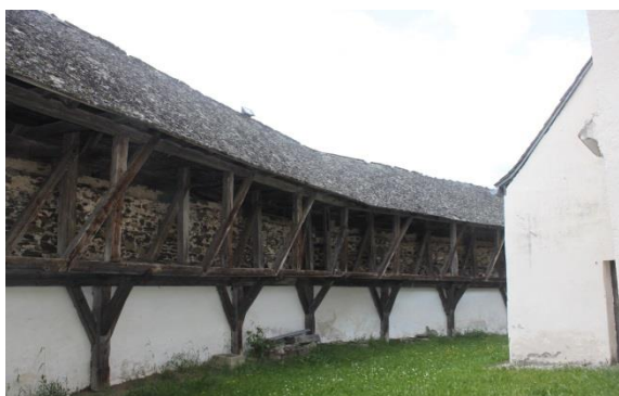
Slika 20: Kneže, eden izmed redkih primerov ohranjenega lesenega obrambnega hodnika z ognjevarno streho iz skrila (vir: lastni arhiv)
