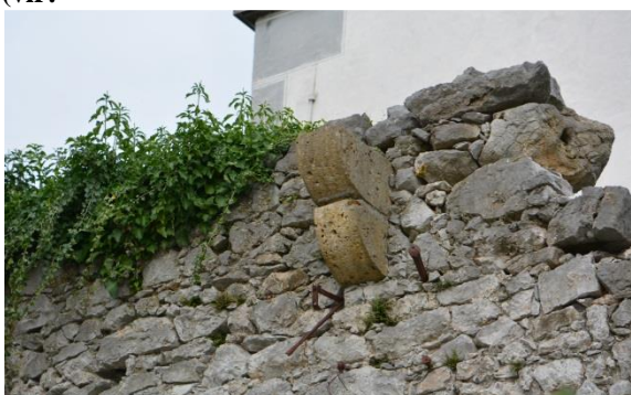
Slika 25: Ihan, kamnita konzola izpostavljenega obrambnega pomola (vir: lastni arhiv)
