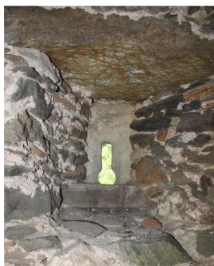
Slika 23: Djekše, vzdana strelna lina v obrambnem stolpu (vir: lastni arhiv)
