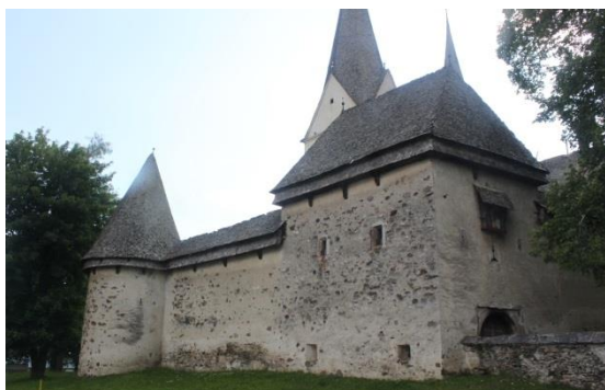
Slika 26: Djekše, ohranjeni obrambni sistem s stolpi, pokritimi obzidnimi hodniki in strelnimi linami
