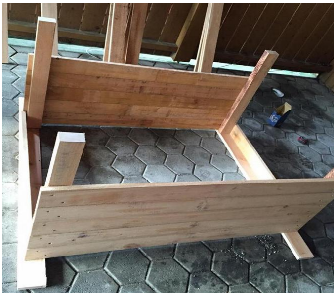
Slika 24: Začetek izdelave balkonske grede (Vir lasten)
