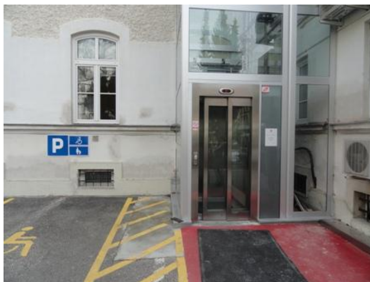
Fotografija št. 5: Dvigalo na Mestni občini Maribor (Vir: avtorici naloge)
