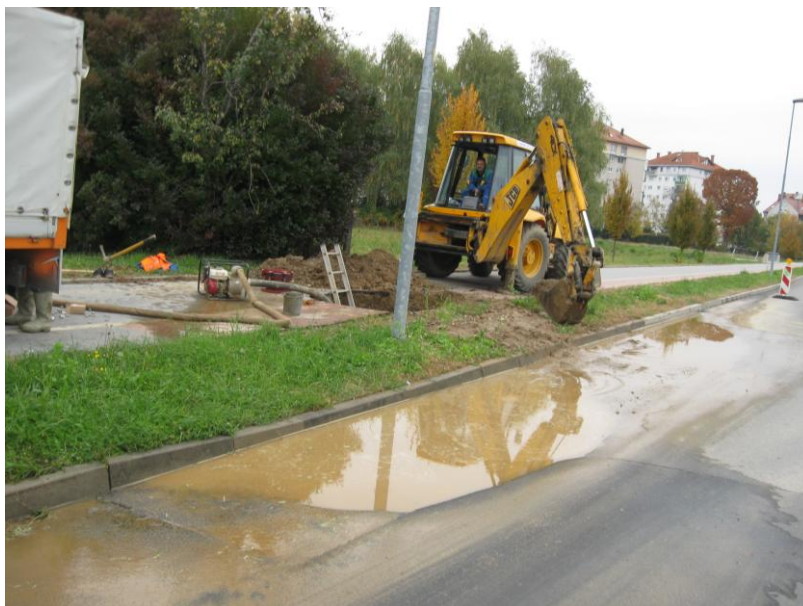
Slika 9: Izkop začasnega dostopnega jaška (Vir: Marjan Erjavec, MB Vodovod)
