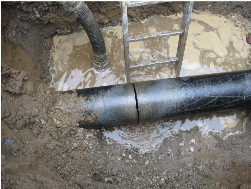
Slika 8: Napaka na LITOŽELEZNI cevi (Vir: Marjan Erjavec, MB Vodovod)
