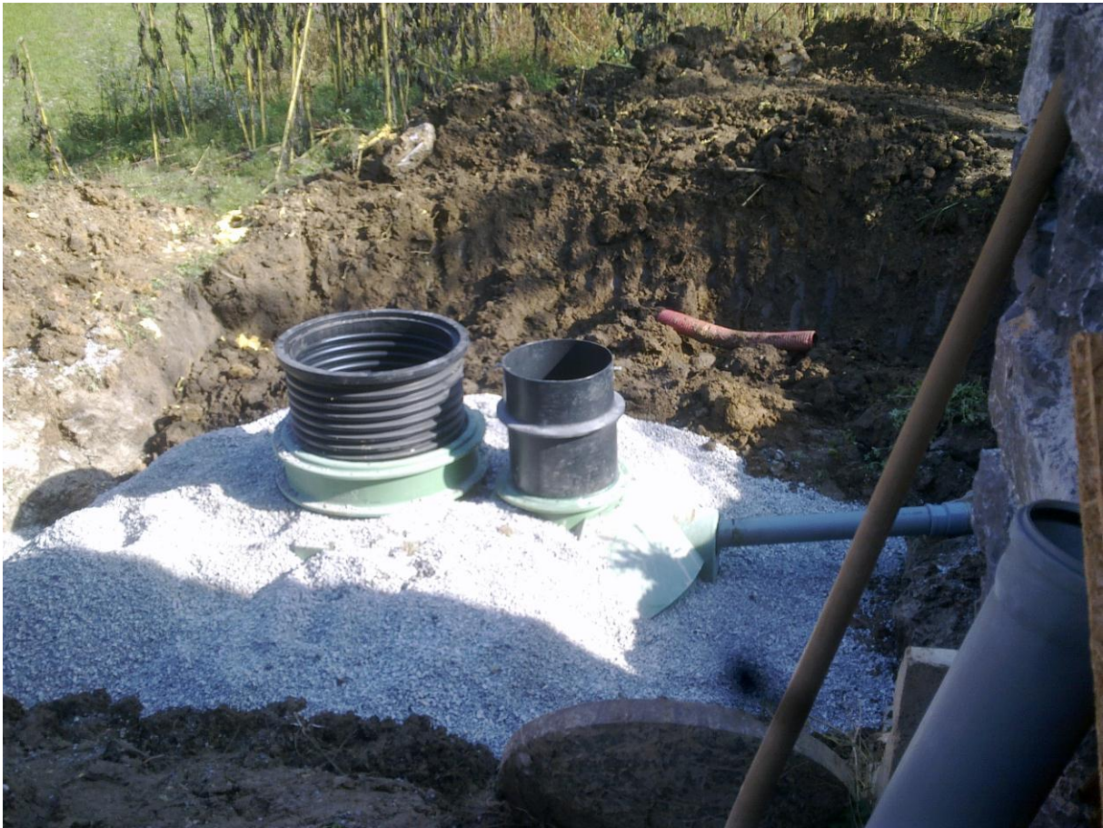
Slika 10. Prikaz povezal in pravilen zakop
