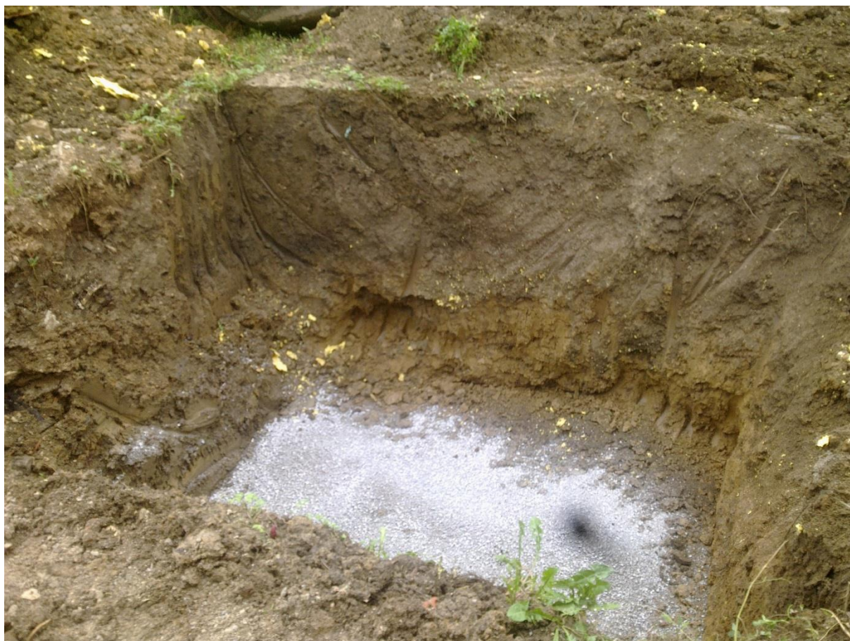
Slika 9. Gradbena jama pripravljena za zakop male čistilne naprave
