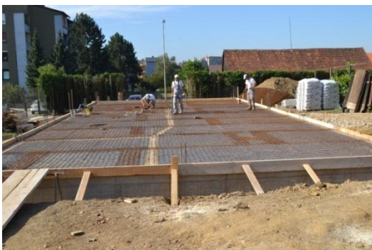
Slika 23: Armirana temeljna plošča
