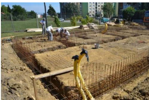
Slika 10: Armiranje temeljev nad terenom
