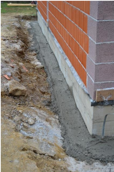
Slika 51: Posteljica za drenažno cev
