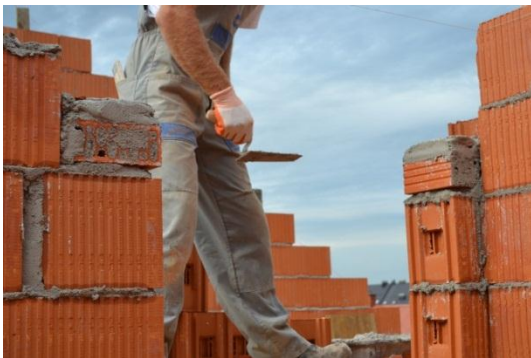
Slika 30: Priprava višine za vstavljanje preklade
