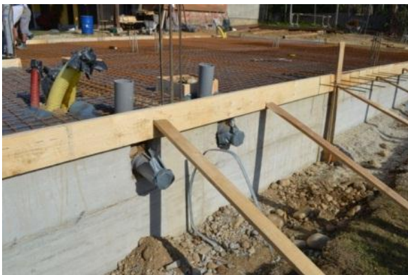
Slika 22: Opaž temeljne plošče
