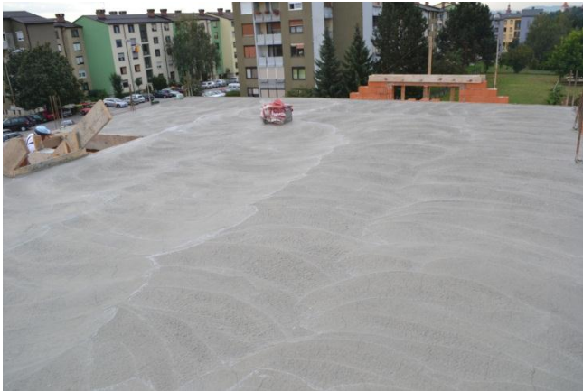
Slika 46: Zabetonirana stropna plošča
