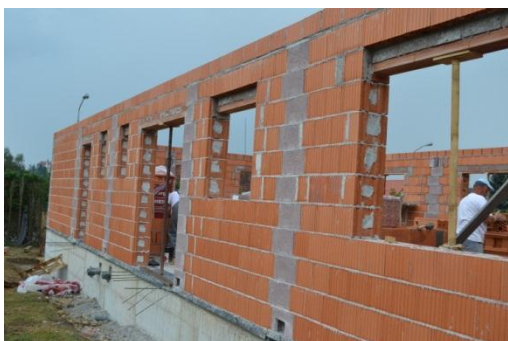
Slika 29: Zazidani zunanji zidovi v pritličju
