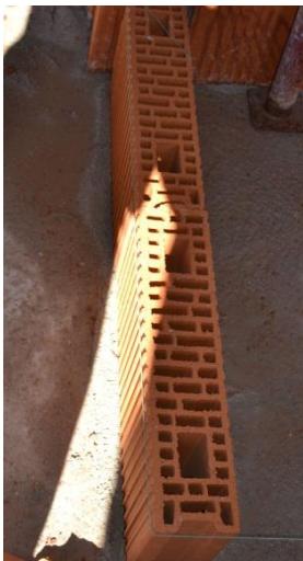
Slika 47: Notranja predelna stena
