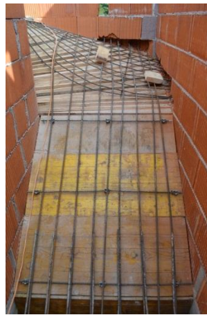
Slika 43: Narejen spodnji opaž in položena armatura
