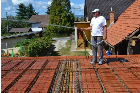
Slika 41: Namakanje stropne plošče pred betoniranjem
