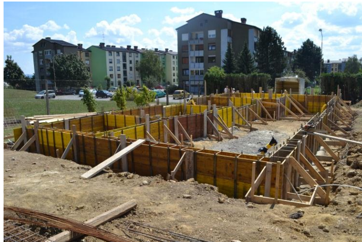
Slika 13: Pripravljen opaž pasovnih temeljev
