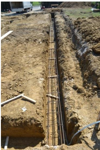
Slika 9: Polaganje armature v temelje
