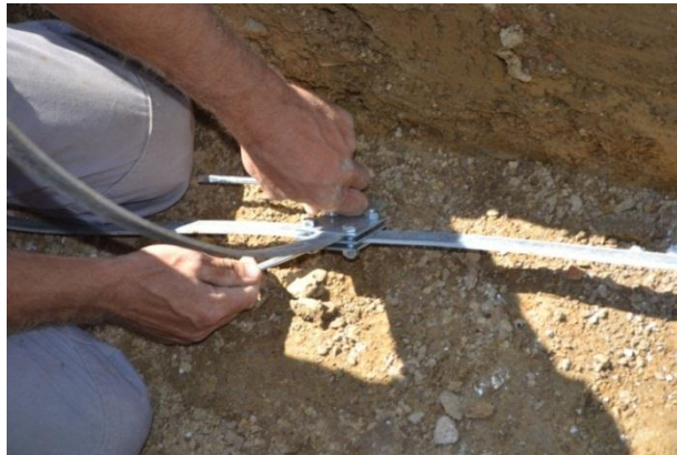
Slika 7: Spajanje valjenca s križnimi sponkami
