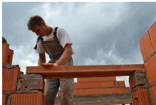
Slika 31: Vstavljanje preklade
