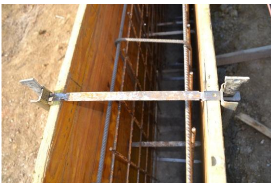
Slika 14: Povezava opažnih plošč z distančnikom-veznikom
