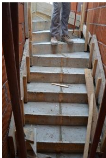
Slika 50: Razopaževanje stopnic
