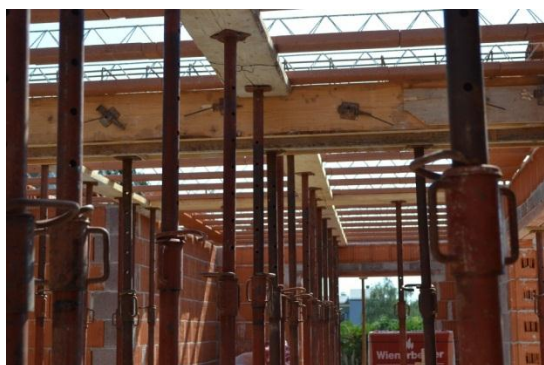
Slika 38: Podprti nosilci
