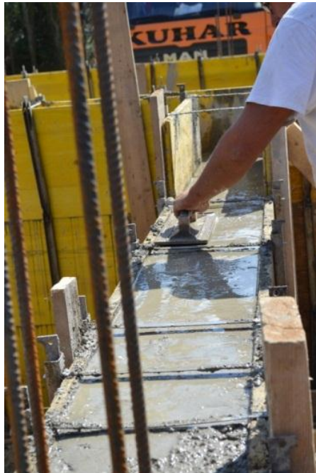
Slika 16: Poravnava pasovnih temeljev na določeno višino
