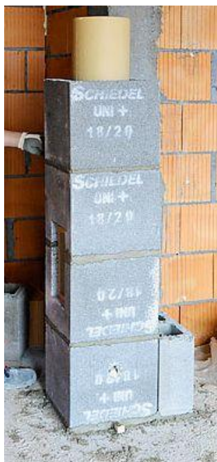
Slika 37: Zidanje Schiedel dimnika
