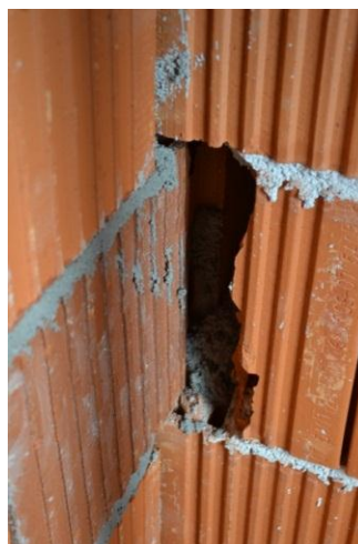
Slika 36: Povezava zidu
