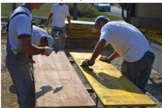
Slika 20: Čiščenje opažnih plošč
