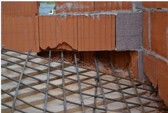
Slika 42: Sidranje armature v zid
