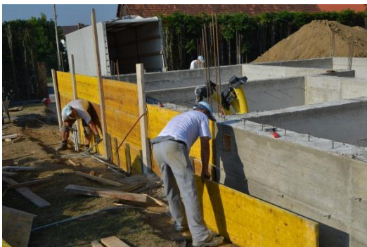
Slika 19: Odstranjevanje opažnih plošč
