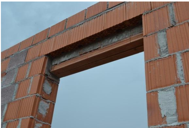
Slika 32: Vstavljen preklada nad oknom z odprtino za vgradnjo rolet
