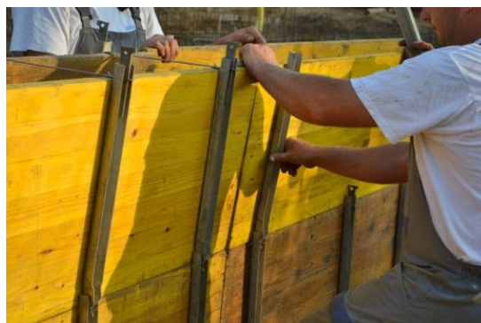
Slika 15: Opaževanje pasovnih temeljev
