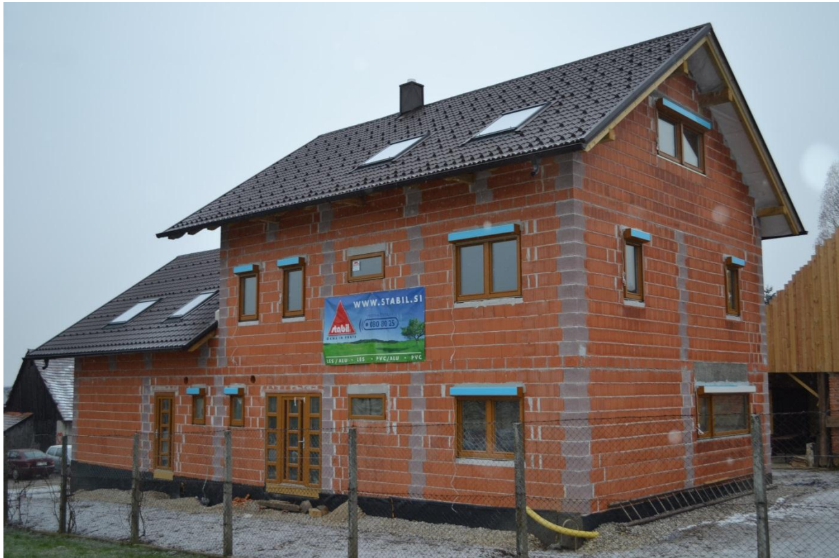
Slika 55: Hiša v 4. gradbeni fazi
