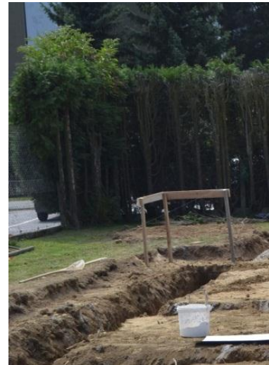
Slika 5: Postavljen profil
