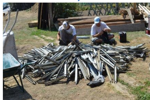
Slika 21: Čiščenje opažnih veznikov
