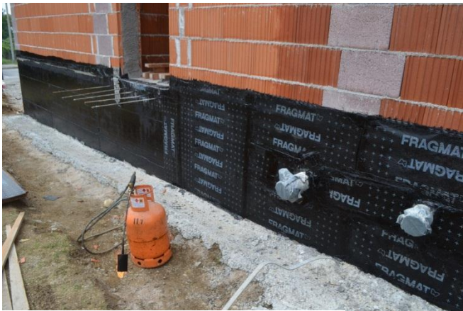
Slika 25: Vertikalna hidroizolacija
