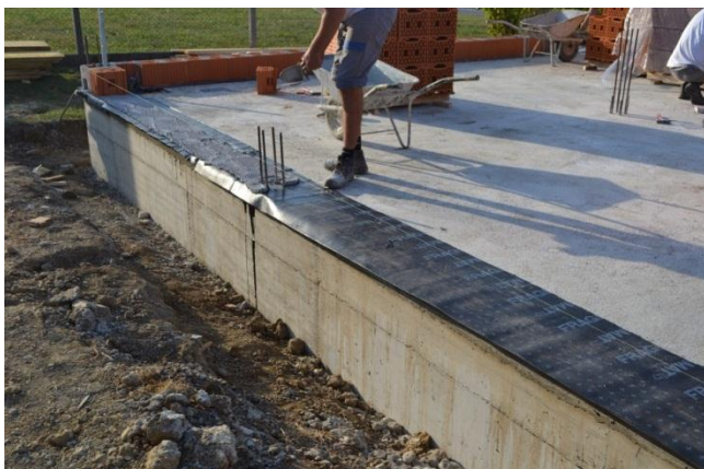
Slika 26: Pripravljena hidroizolacija za zidanje zunanjih zidov
