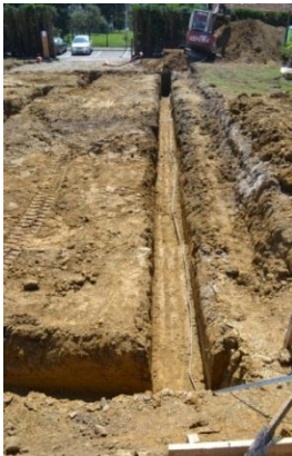
Slika 8: Položen valjenec
