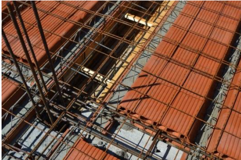
Slika 40: Del armature v stropni plošči
