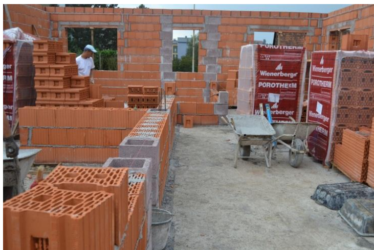
Slika 35: Zidanje notranjih nosilnih zidov
