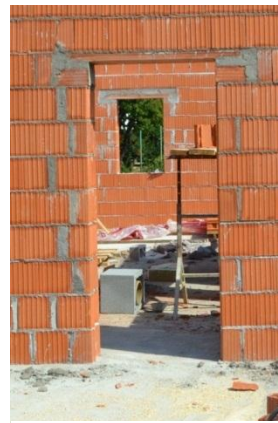
Slika 33: Vstavljen preklada nad vrati
