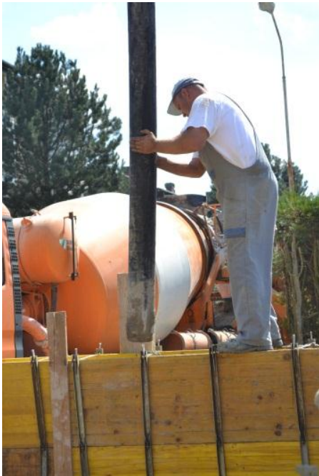
Slika 17: Betoniranje pasovnih temeljev
