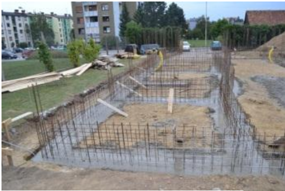
Slika 11: Zabetonirani temelji
