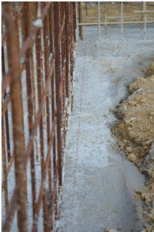
Slika 12: Crta, ki označuje do kod sega notranji del opažne plošče
