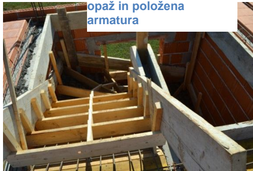
Slika 45: Stopnice pripravljene na betoniranje
