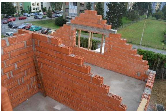
Slika 49: Zazidani požarni in kolenčni zidovi
