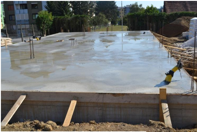
Slika 24: Zabetonirana temeljna plošča
