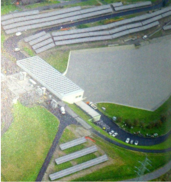
Slika 3 Sončna elektrarna na HE Zlatoličje moči 1MW
