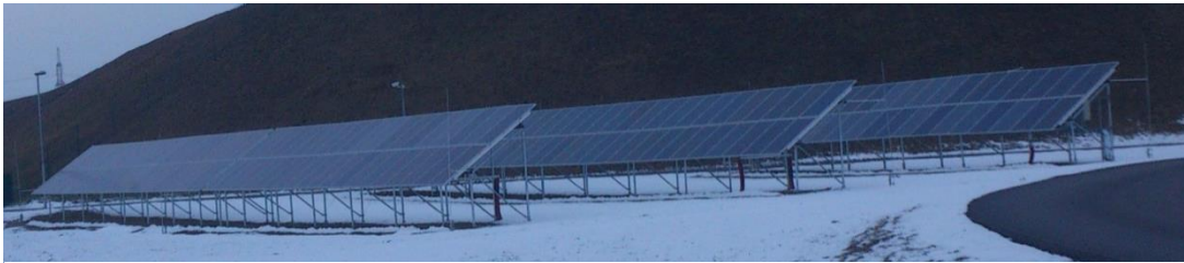
Slika 8 Dokončan segment F
