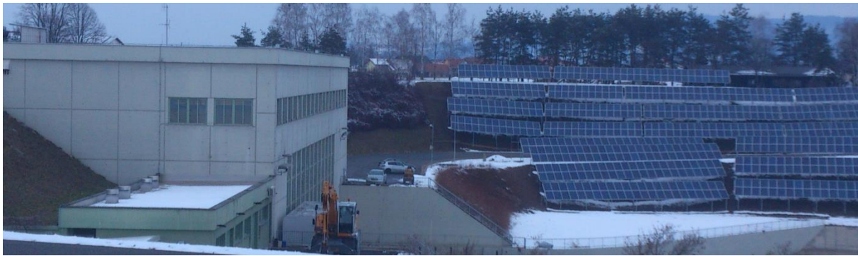
Slika 9 Dokončani segmenti B, C, D, E
