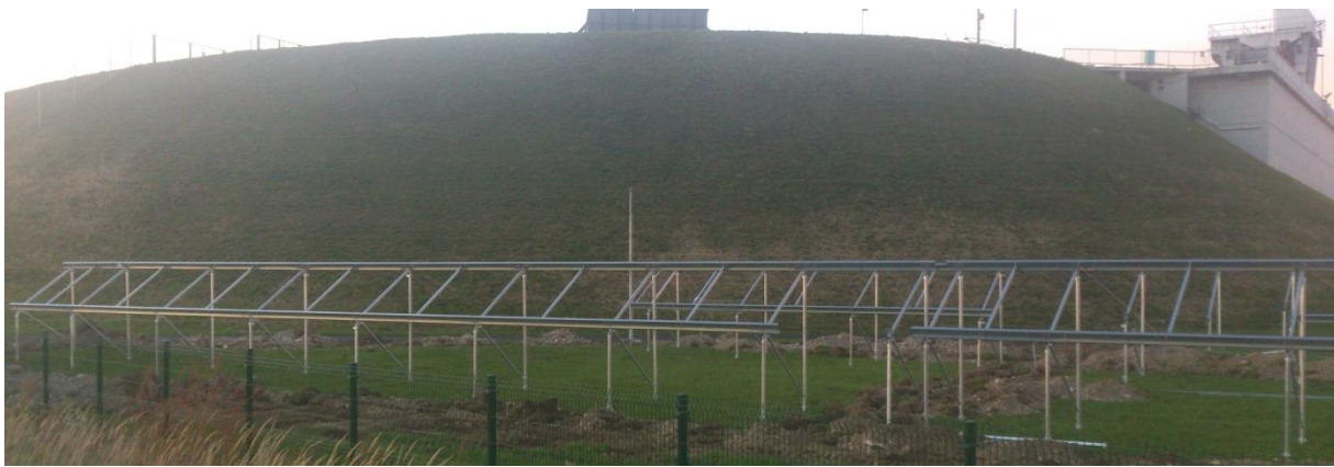
Slika 5 Začetek montaže segmenta F
