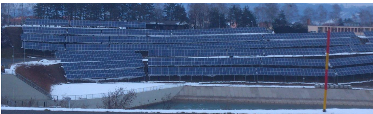
Slika 7 Dokončani segmenti B, C, D, E
