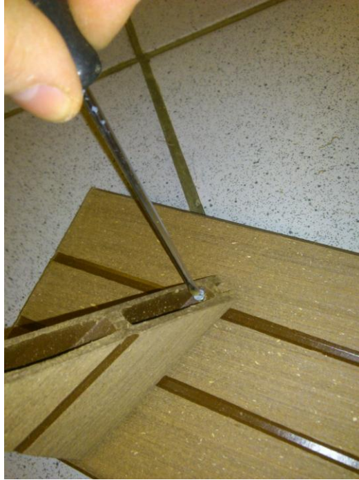
Slika 12: Pritrditev podpornih nogic vir:(lastna slika)
