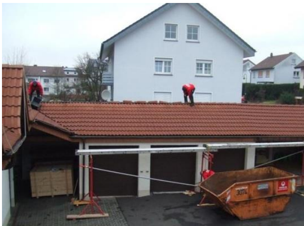
Slika 15: Slika strehe pred vzpostavitvijo fotovoltaike
