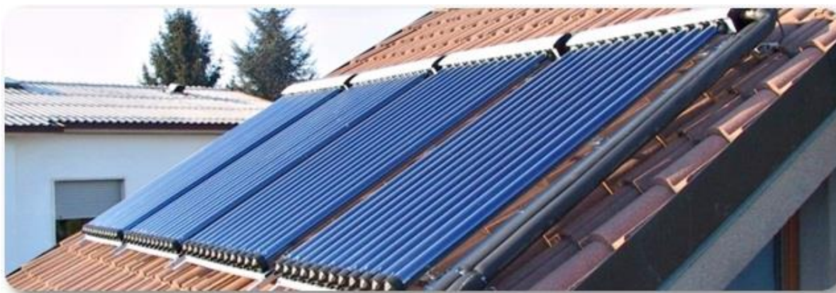
Slika13 : Sončni kolektor z vakuumskimi cevmi
