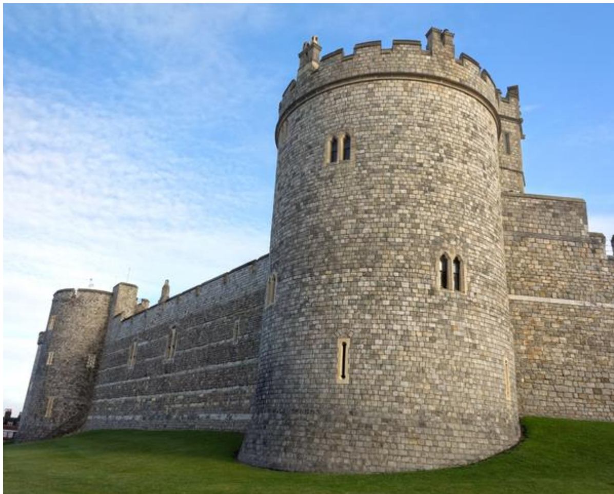
Slika 1.4.1.2: Primer obrambnih stolpov
