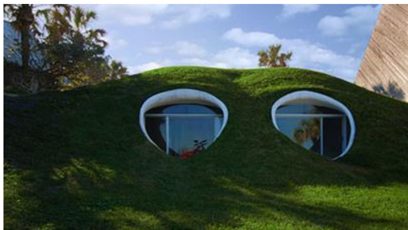
Slika 1.7.4: Slika vkopane hiše
