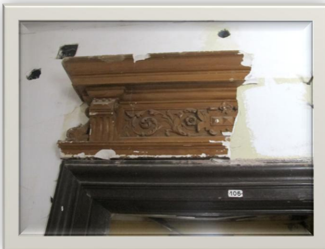
Slika 7. Ostanki vratnih opažev
